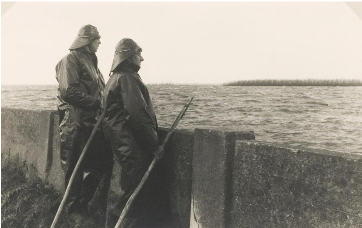
Twee dijkwachters bij de muraltmuur op de Oostdijk in december 1954, kijkend over de ondergelopen buitenpolder. (collectie Westbrabants Archief)
