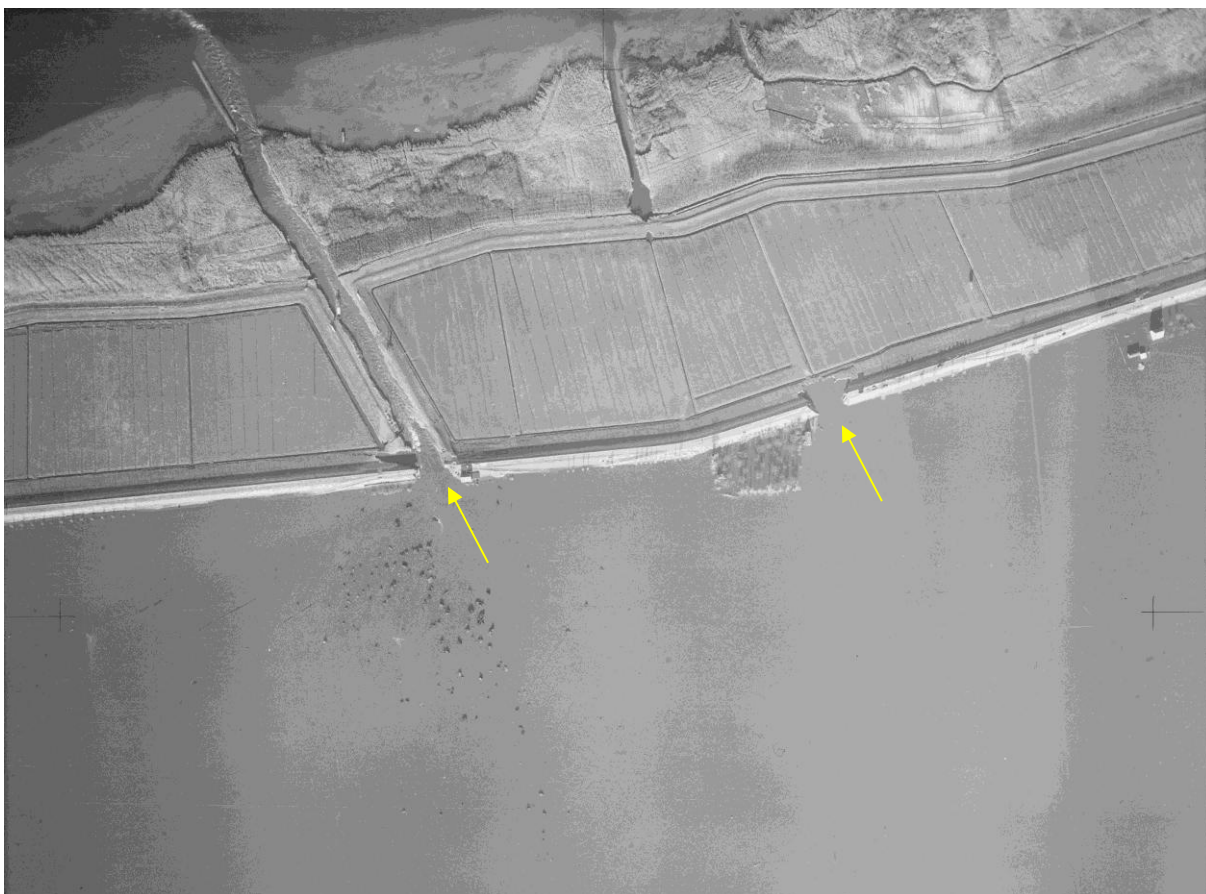
Een luchtfoto van de twee tijdens de Watersnoodramp van 1953 opgetreden doorbraken in de Oostdijk, bij de Nieuwe sluis. Ook de muralmuur is deels weggespoeld. (collectie Nederlands Instituut voor Militaire Historie)
