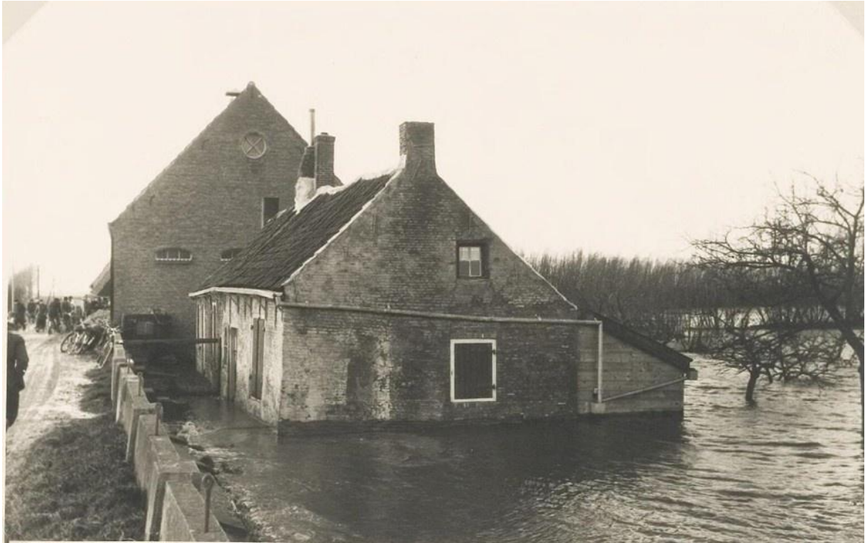
De muraltmuur ter hoogte van Oostdijk 3 tijdens een stormvloed in december 1954. Het adres bestaat thans niet meer, maar vermoedelijk is de foto in de buurt van het nog wel bestaande Oostdijk 1 in Bovensluis genomen. De muraltmuur op de voorgrond bestaat uit de kenmerkende muurmoten en muurlijsten. De muurmoten beschikken steeds over een meegestort oog, vermoedelijk een hijsoog. (collectie Westbrabants Archief)
